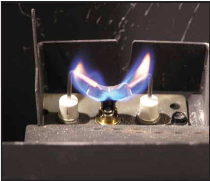
Figure 3.1 Forme de la flamme d'une veilleuse Intellifire
