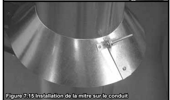
Figure 7.15 Installation de la mitre sur le conduit
