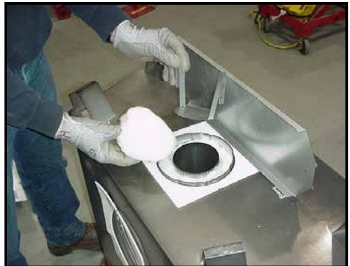
**Figure 6.5** Retirez le panier d'isolation et l'isolant blanc du centre du conduit d'évacuation des gaz.
