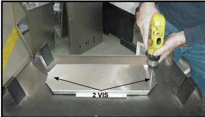
**Figure 6.1** Pour le conduit supérieur, retirez les deux vis maintenant en place l'écran thermique supérieur. Pour le conduit arrière, voir la page suivante.
