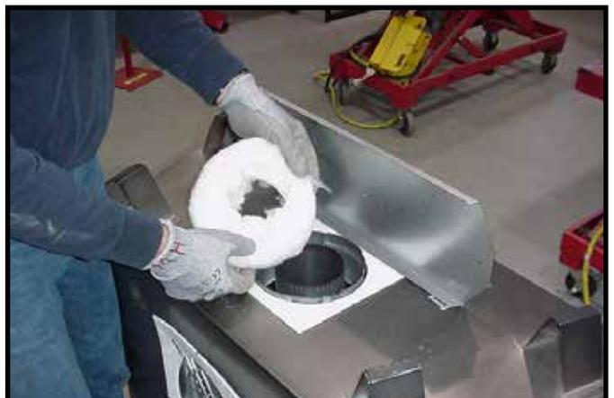
**Figure 6.6** Retirez l'isolation du conduit d'évacuation des gaz extérieur.
