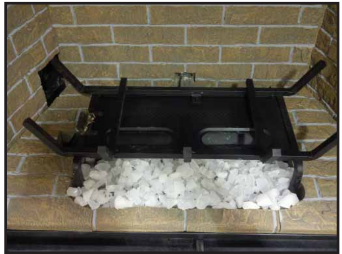
Figure 11.9. Zone de braises couverte avec du Teco-Sil
