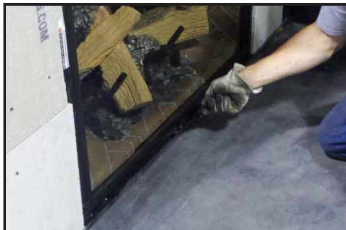
Figure 11.8. Sécuriser les clips de verre inférieurs
