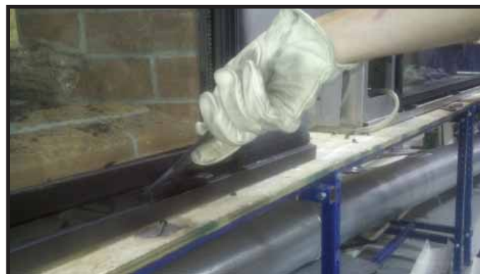
Figure 11.3. Insérer l'outil du clip de vitre
