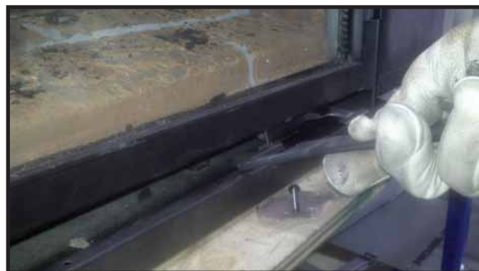
Figure 11.2 Emplacement de l'outil du clip de vitre
