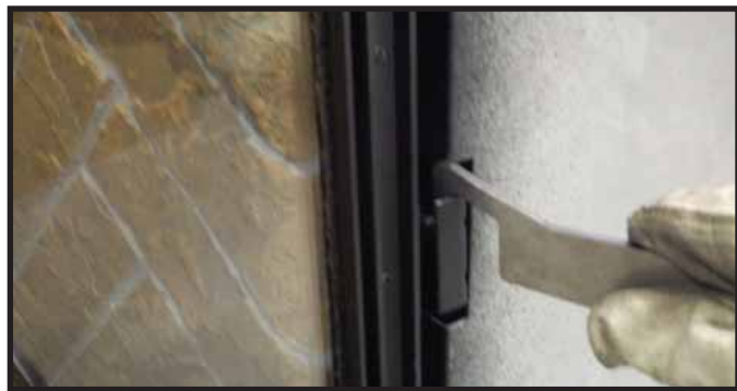
Figure 11.7. Sécuriser les clips de verre latéraux
