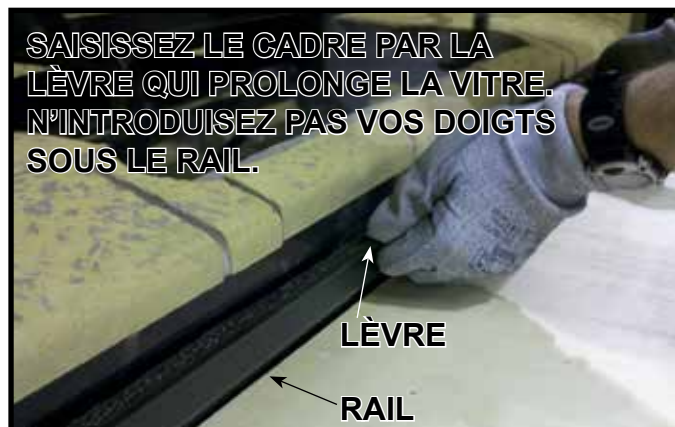
Figure 14.11. Installation de la vitre
