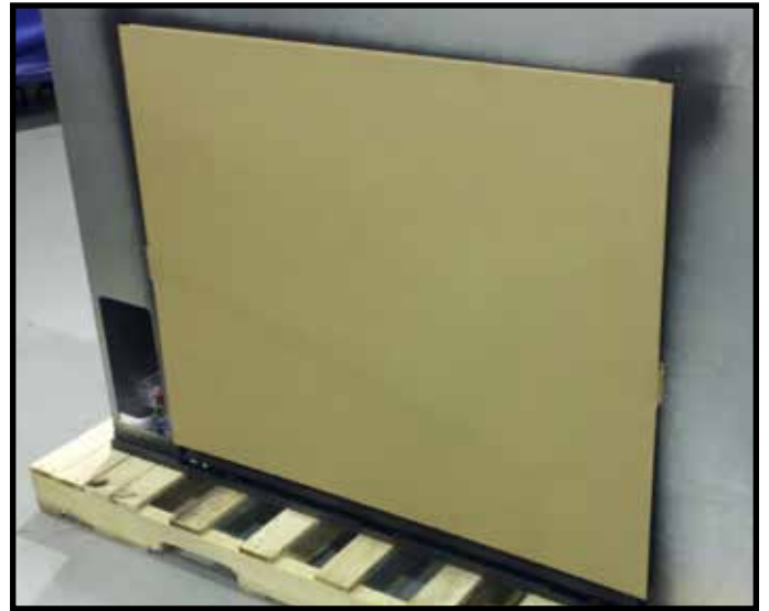
Figure 13.5. Installation de la feuille de protection
