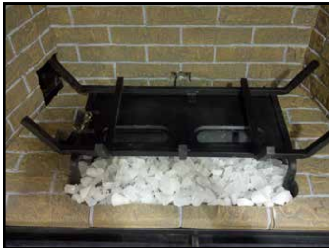
Figure 14.2. Surface des braises de verre couverte avec Teco-Sil
