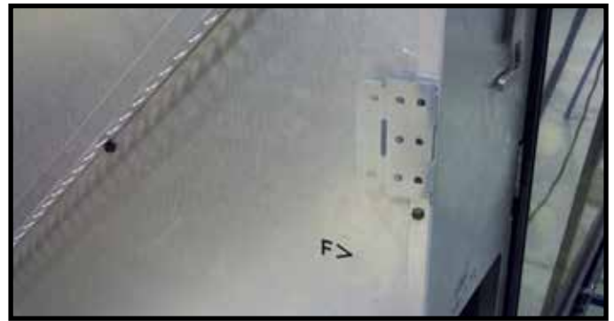
Figure 9.3 Patte à clouer du côté en position d'expédition
