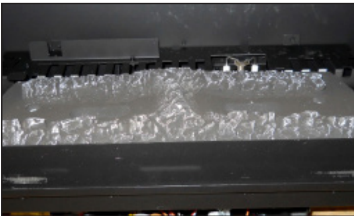
Figure 10.6 Installation du réfractaire arrière
