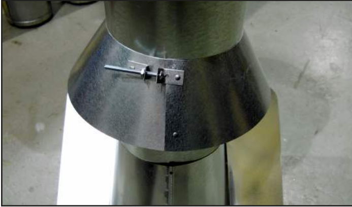
Figure 7.14 Insérer le boulon dans les supports
