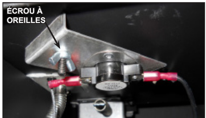
Figure 8.5 Interrupteur à capteur de température installé
