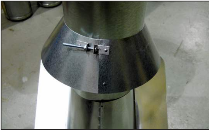
Figure 7.14 Insérer le boulon dans les supports
