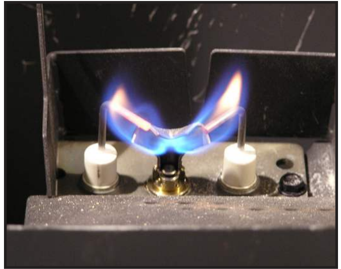
Figure 3.2 Modèles de flamme de la veilleuse IPI
