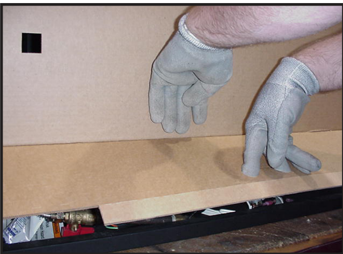
Figure 13.8 Ouverture du panneau d'accès inférieur
