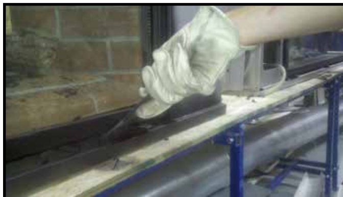
Figure 11.3. Insérer l'outil du clip de vitre
