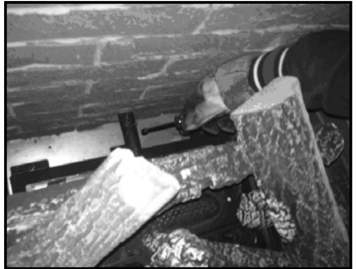
Figure 1. Emplacement de l'obturateur d'air
