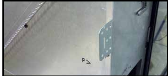
Figure 6.4 Languette à clouer pliée vers l'extérieur pour l'installation
