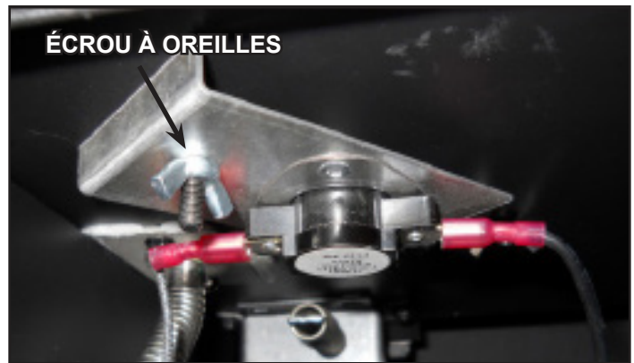
Figure 8.5 Interrupteur à capteur de température installé
