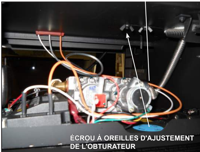
Figure 9.1 Obturateur d'air
