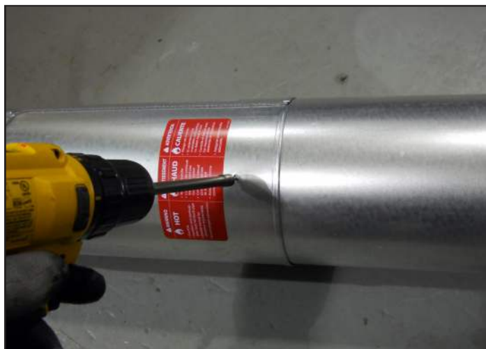
Figure 7.4 Vis sur la section coulissante
