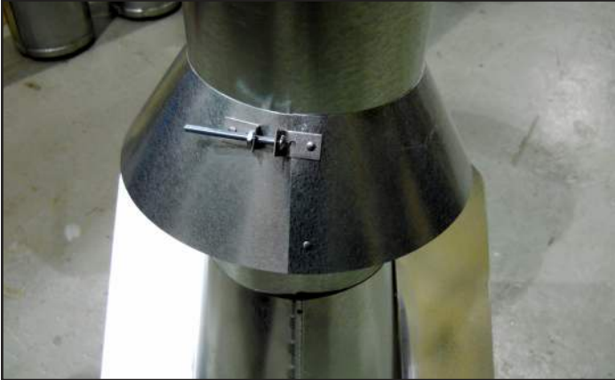
Figure 7.14 Insérer le boulon dans les supports
