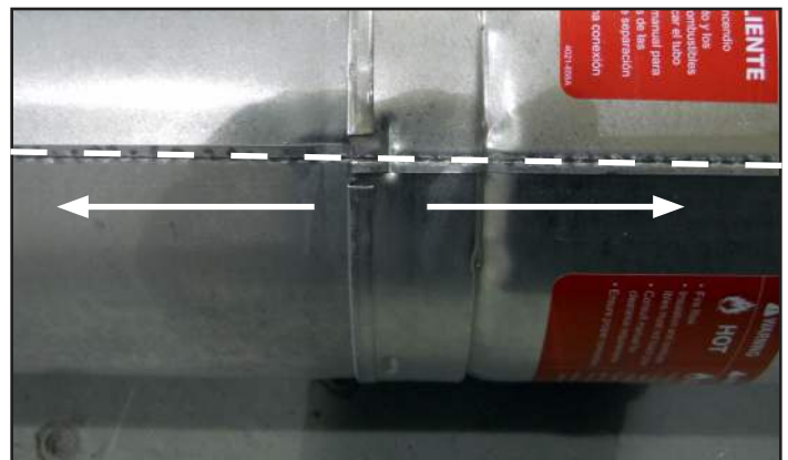
Figure 7.8 Aligner et démonter les sections de conduit d'évacuation
