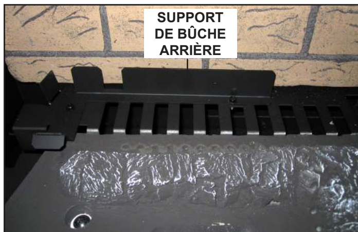
Figure 10.4 Installation du réfractaire arrière
