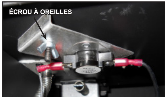
Figure 8.5 Interrupteur à capteur de température installé
