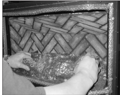
Figure 6.2 Soulevez le brûleur hors de l'ouverture du foyer.
