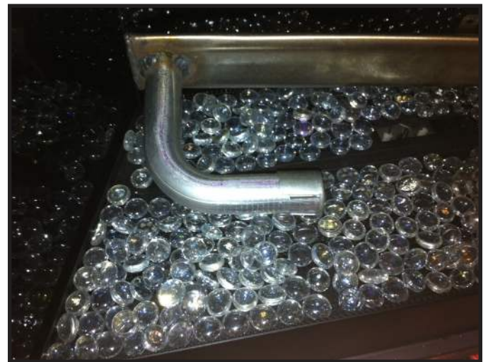
Figure 14.5 Obturateur d'air
