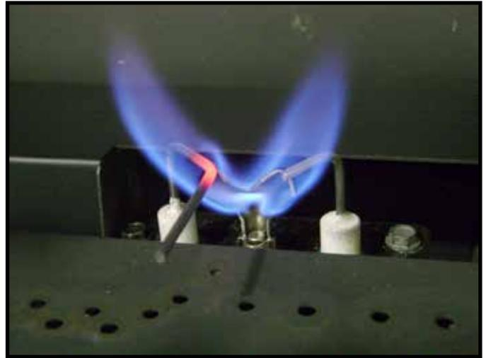
Figure 3.1 Modèles de flamme de la veilleuse IPI
