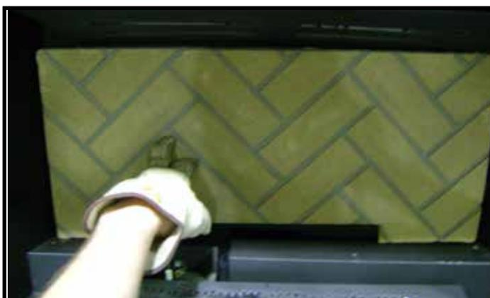
Figure 2. Installer la brique réfractaire arrière
