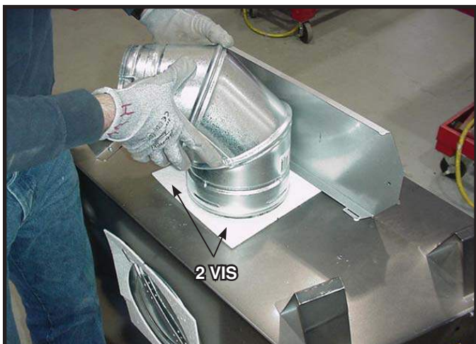
Figure 9.9 Pour attacher la première section du tuyau d'évacuation, utiliser le joint en fibre de verre pour sceller le premier composant du conduit à l'enveloppe extérieure du foyer. Utiliser 2 vis autotaraudeuses pour attacher le joint à l'enveloppe extérieure.
