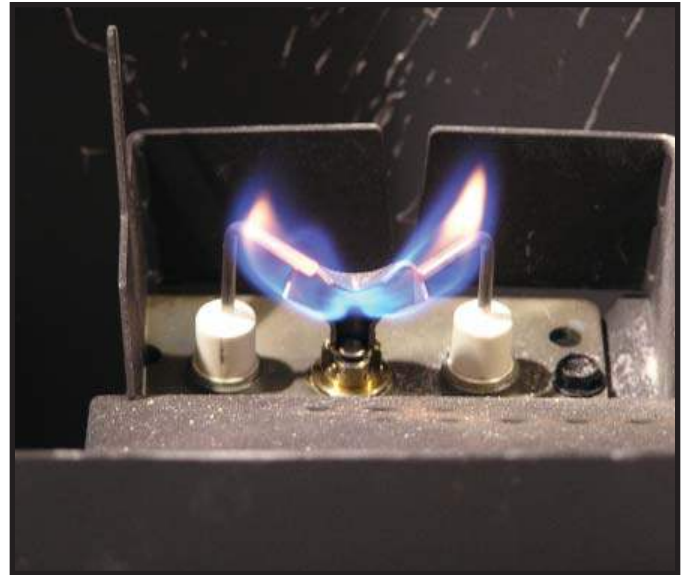
Figure 3.1 Forme de la flamme d'une veilleuse Intellifire
