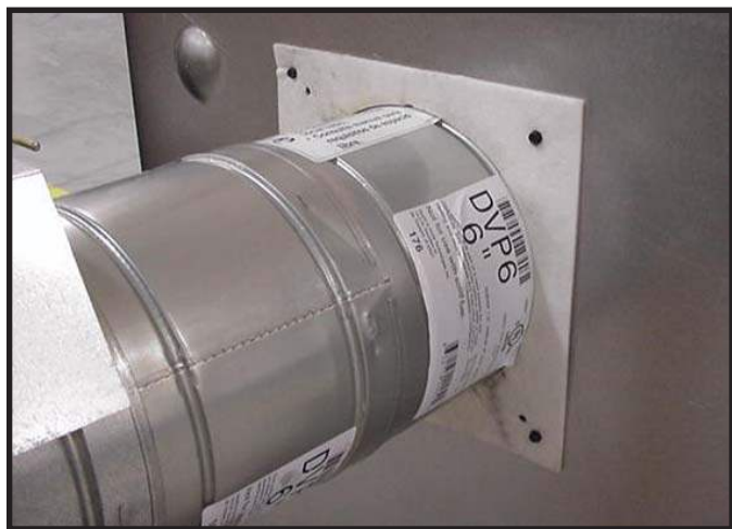
Figure 9.16 Attacher la première section du conduit d'évacuation (celle-ci s'enclenchera). Glisser le joint isolant dans la section du conduit contre l'appareil et au-dessus des attaches. Utiliser deux vis autotaraudeuses pour attacher le joint à l'enveloppe extérieure.
