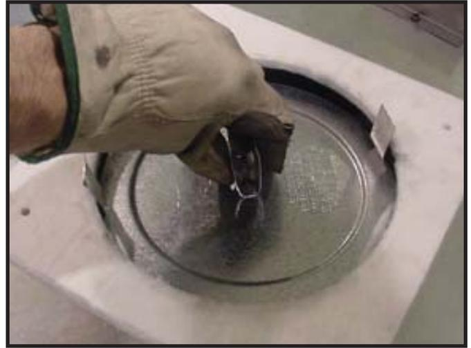
**Figure 9.3** Plier vers le haut les parties centrales de la bande de retenue et les utiliser pour enlever le capuchon d'évent.
