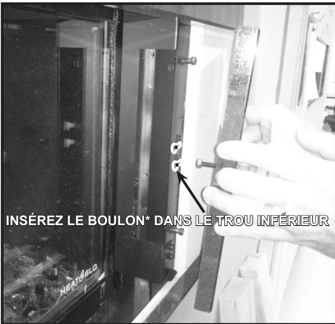
Figure 10.25. Installer les pièces latérales de granite
