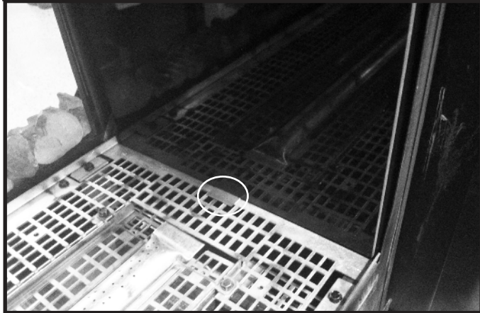
Figure 10.8 Position du clip de vitre et installation du panneau de verre
