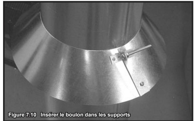
Figure 7.10 Insérer le boulon dans les supports
